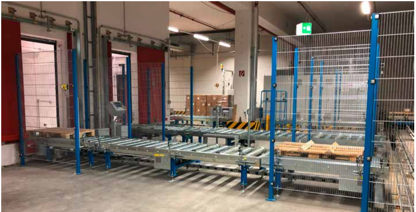
Im 1. OG wurde der bestehende Verteilerwagen (rechts im Bild) an die beiden Vertikalumsetzer angeschlossen.
